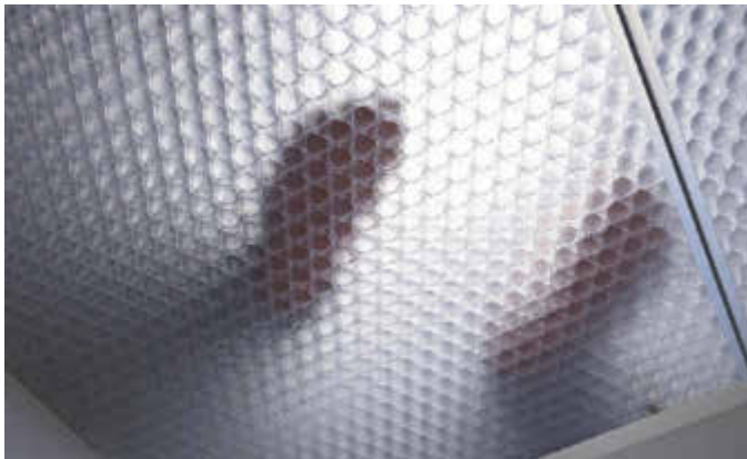
Die zweigeteilte Klappe aus Kunststoff-Wabenkern-Verbundwerkstoff ist begehbar und lichtdurchlässig
