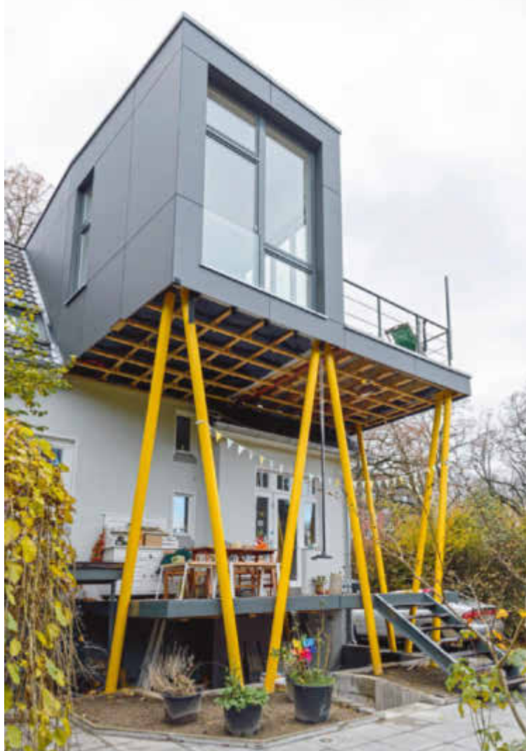
Die Diagonalstützen dienen zur Aussteifung des schwebenden Bauvolumens
