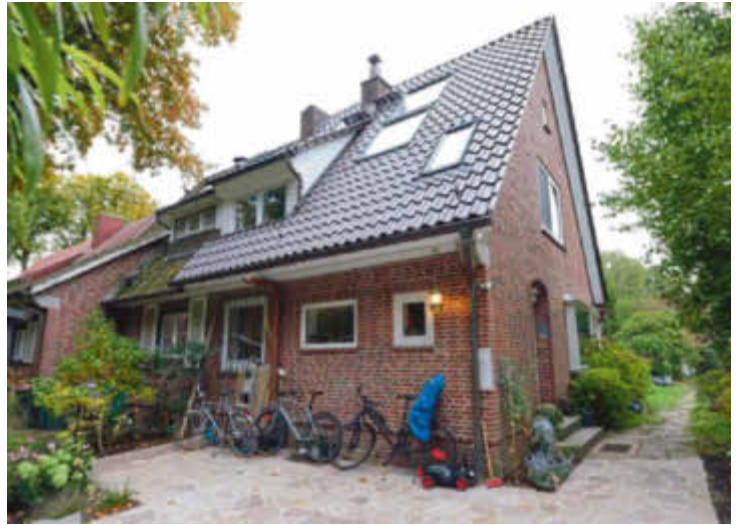
Die 1950er-Jahre-Doppelhaushälfte bleibt von außen in ihrem zurückhaltenden Charme erhalten
