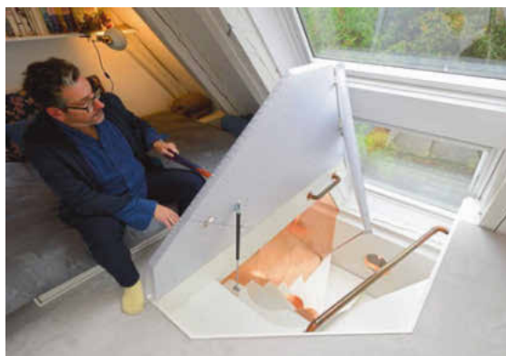
Die lichtdurchlässige Bodenklappe faltet sich mit einer Pendelstabführung unter der Dachschräge zusammen
