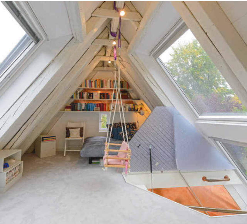
Treppenausgang zum Spitzboden mit Aufsparrendämmung und großen Dachflächenfenstern
